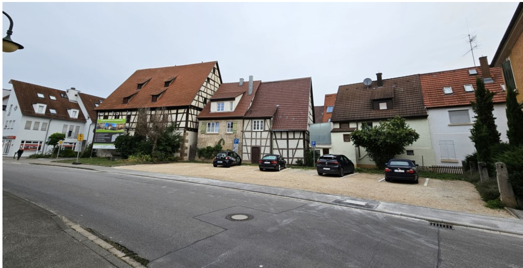
Südansicht der Gebäude Inselstraße 13, 15 und 17 (unmaßstäblich)
