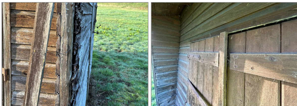
Abb. 13: Holzhütte mit Tagesquartierpotenzial für Fledermäuse (Fotos HPC 15.03.2024)
